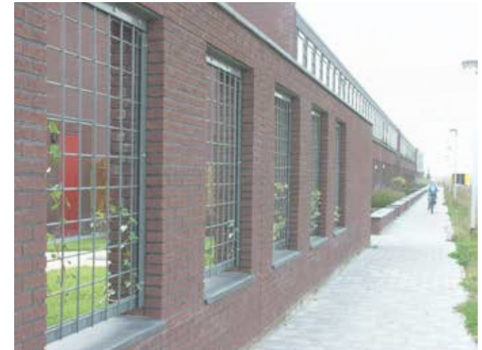
Een gecombineerde erfafscheiding van metselwerk en hekwerk met groen passend bij de kleuren van de gevel
