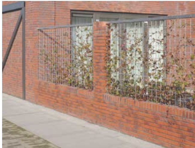
Een gecombineerde erfafscheiding van metselwerk en hekwerk met groen passend bij de kleuren van de gevel
